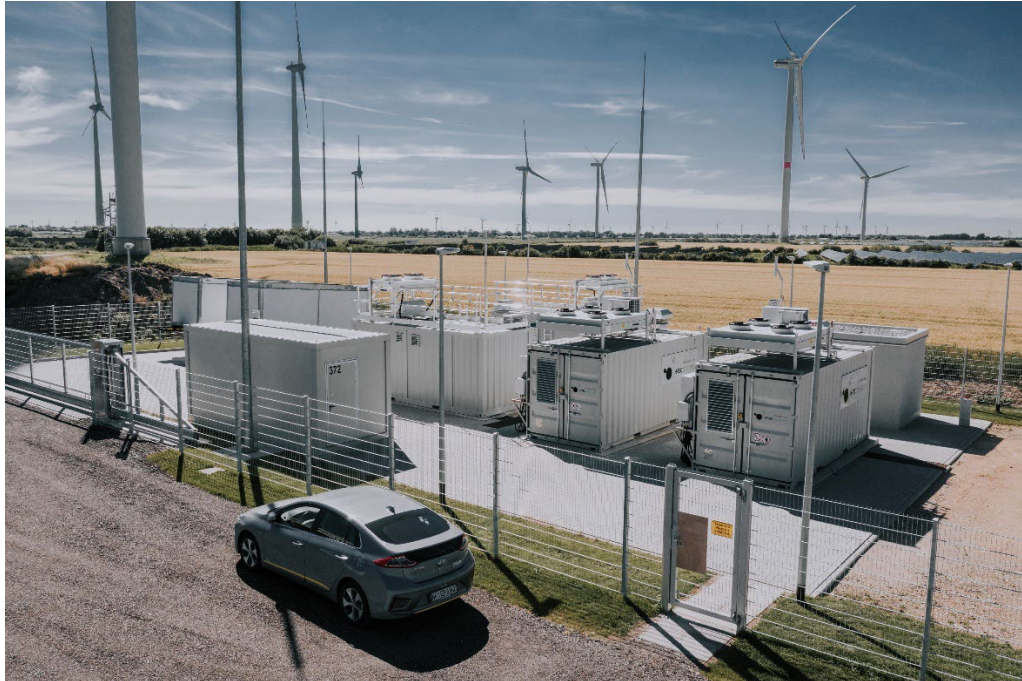
Die Wasserstoffproduktionsanlage im nordfriesischen Bosbüll.
