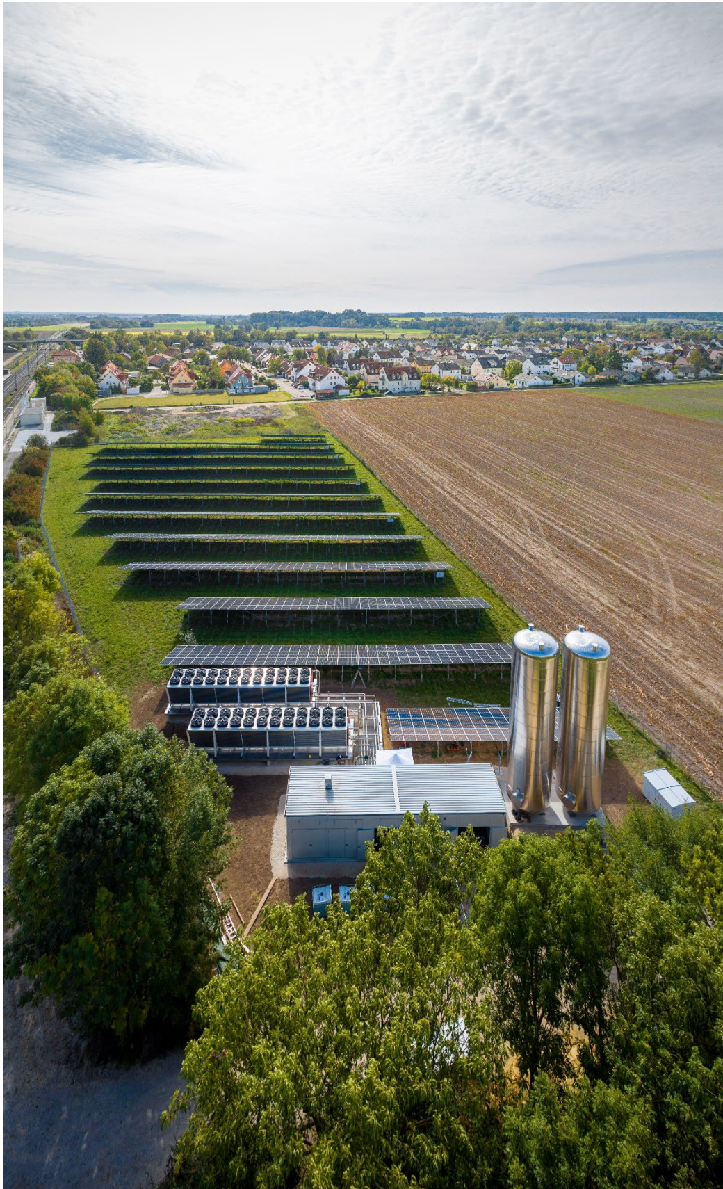
BU2: Die Heizzentrale in Mertingen von oben.
