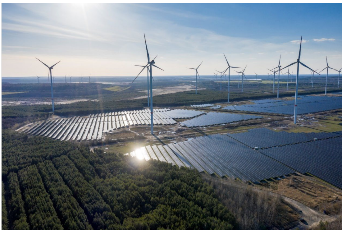
Strom für Haushalte, Unternehmen und zur Produktion von grünem Wasserstoff: Der 300-MW-Solarpark im Energiepark Lausitz in Klettwitz. (Foto: GP JOULE)
