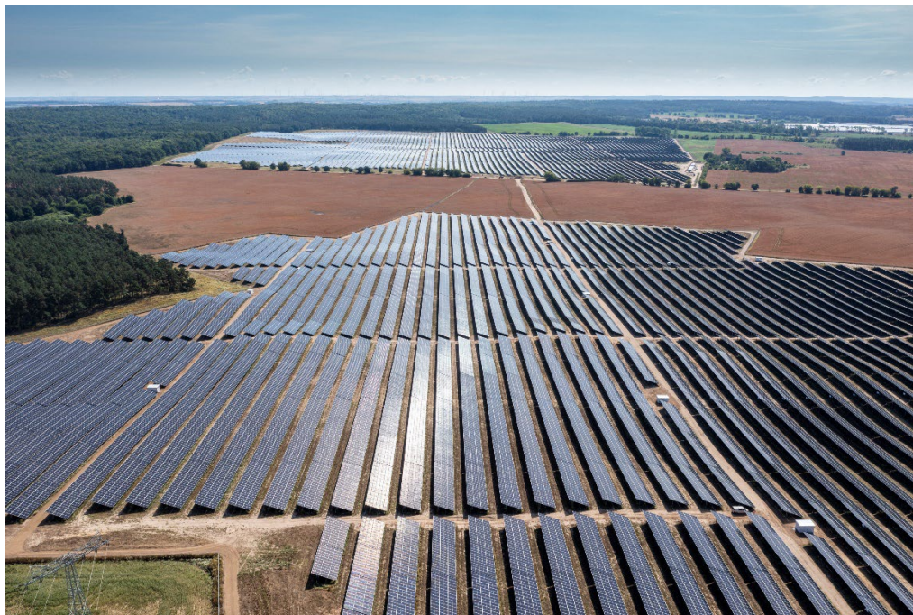
BU 2: Der Solarpark Boitzenburger Land hat eine Leistung von 180,3 Megawatt und wird auf der Fläche von etwa 170 Hektar circa 198 Gigawattstunden CO 2 -freien Strom pro Jahr erzeugen.
