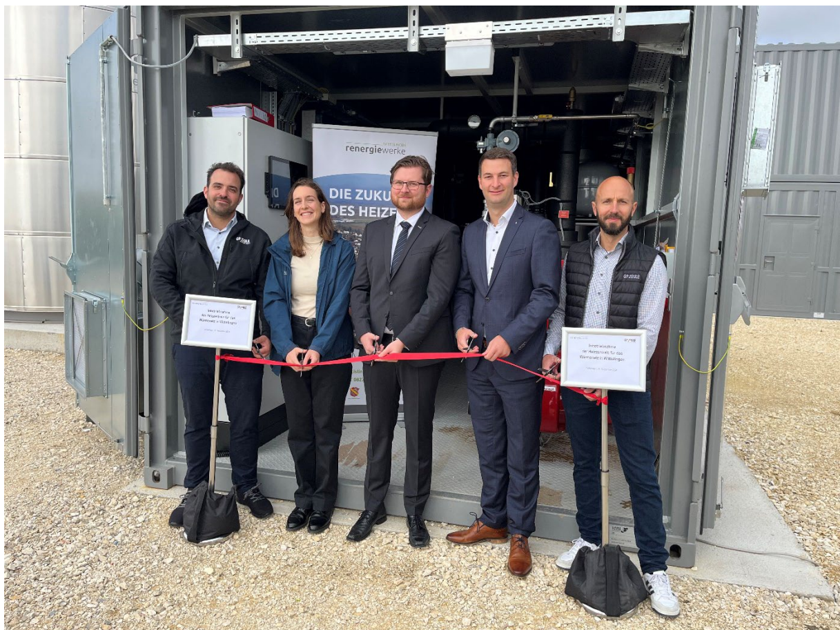
BU 1: Freuen sich über die Inbetriebnahme der Heizzentrale in Wittislingen: (von rechts) Sebastian Herreiner (Stellvertretender Leiter GP JOULE WÄRME), Benjamin Holzinger (Sparkasse Dillingen), Bürgermeister Thomas Reicherzer, Anja Klein (Projektleiterin GP JOULE) und Sebastian Weingarten (Kundenberater GP JOULE).
