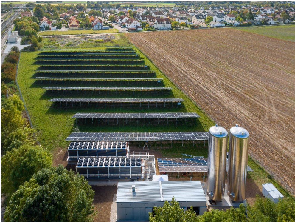
BU 2: PV-Anlage mit Großwärmepumpe und Wärmespeicher im bayerischen Mertingen. Geplant und gebaut von GP JOULE.
