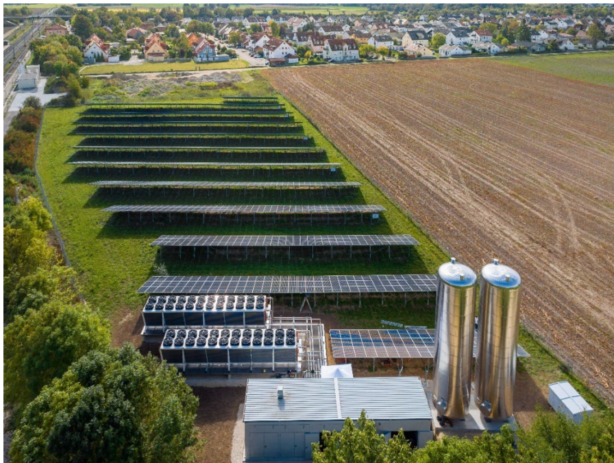
BU 2: PV-Anlage mit Großwärmepumpe und Wärmespeicher im bayerischen Mertingen. Geplant und gebaut von GP JOULE.
